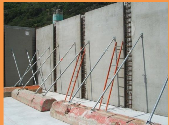
Etalement sur blocs béton
