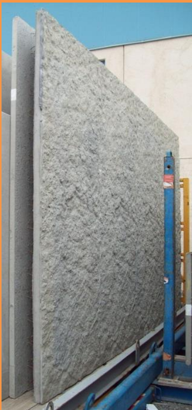
Armacoffré® matricé (matrice Roches 90 bis) : Chaufferie Ilot Ste Anne Toulon.
