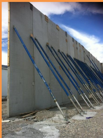
Etalement sur fondations
