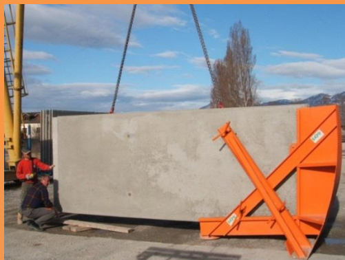
1. Positionnement de l'Armacoffré® dans le retourneur.
