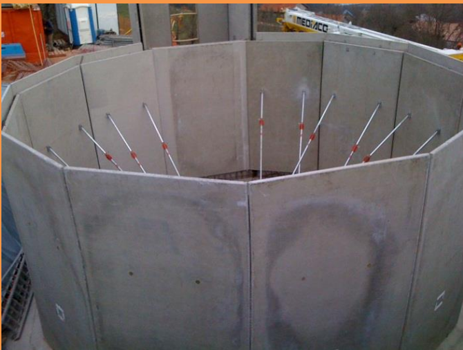
Réservoir à Chorges.
