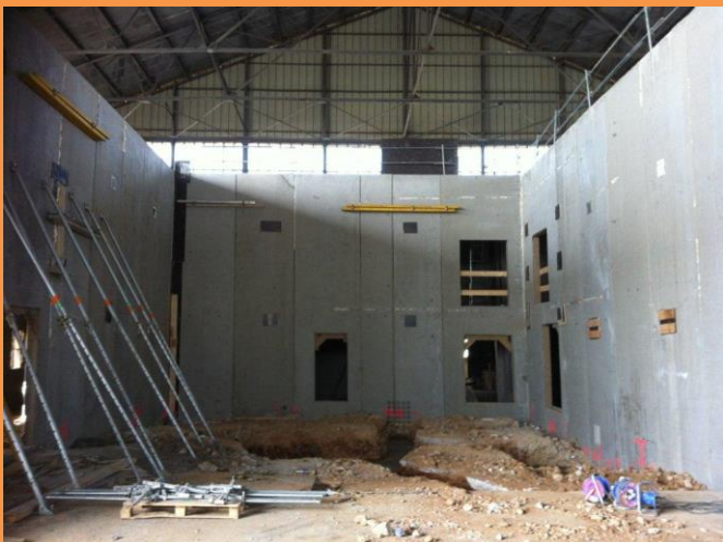
Armacoffré® de grande hauteur : Base aérienne à Nice.
