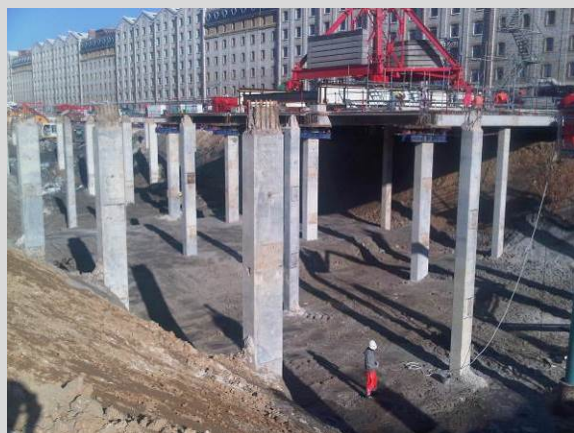
Poteaux préfondés et poutres évidées - © SAPB
