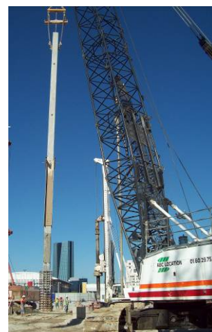
Pose d'un poteau préfondé - © SAPB
