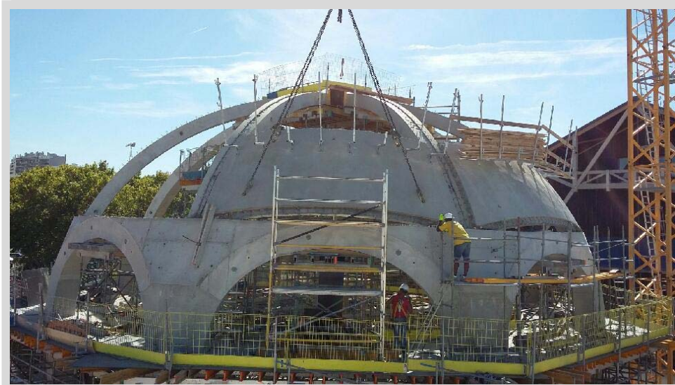
Coupoles et Arches préfa - © SAPB
