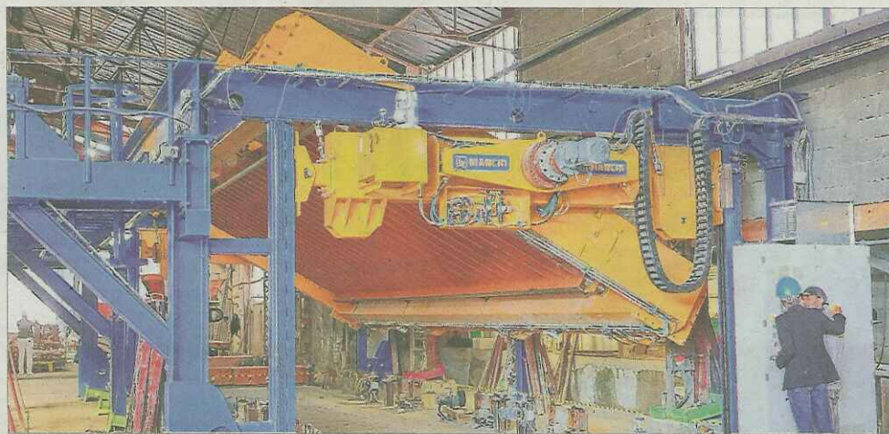
Dans le hall de production "carousel", le retourneur de tables de coffrage est l'un des investissements de l'entreprise en 2014 pour continuer à gagner des marchés. Photo Le DL/Vincent OLLIVIER
